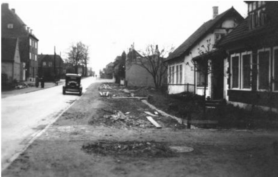
Gladsaxevej før udvidelsen i 1939. Oppe til venstre drejer Lauggårds Alle fra. Vejen blev udvidet ved behændigt at snubbe det meste af husenes forhaver. Fra Gladsaxebilleder.
